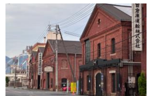
旧呉海軍工廠の煉瓦倉庫群
