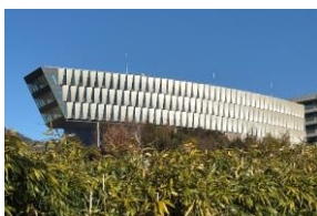
安田女子大学2号館 (石本建築事務所 | 2026)
