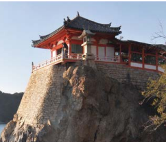
竣工=1570-1573年 所在地=福山市沼隈町能登原阿伏兎1427-1 駐車場あり
