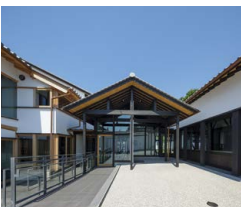
竣工=2022年 所在地=福山市鞆町鞆812番地1 駐車場なし
