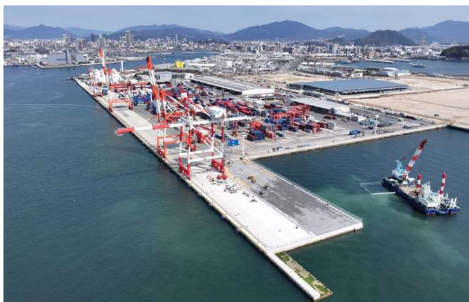
【広島港出島地区 岸壁整備】
