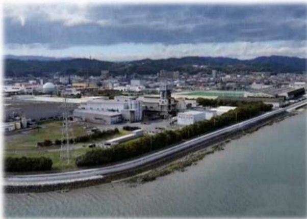
高潮対策（尾道糸崎港海岸高西地区）
