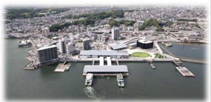
厳島港宮島口地区の整備
