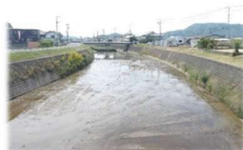
河川堆積土等の除去
