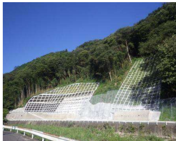
【道路法面对策】
