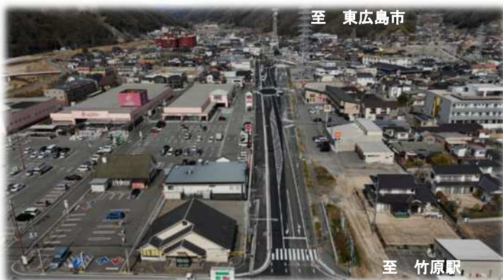
一般国道432号（新開拡幅）（竹原市）の整備
