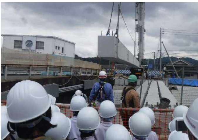
【工事現場見学会（（都）栗柄広谷線・府中市）】
