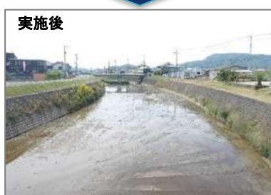
【河川堆積土等の除去】
