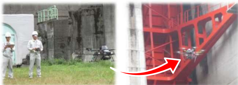
ドローンを活用した施設点検
