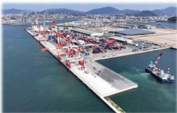
広島港出島地区 岸壁整備
