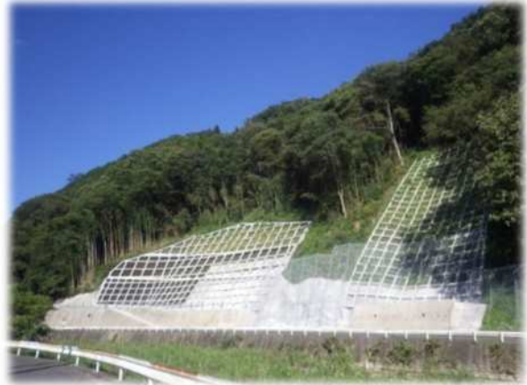
道路法面对策
