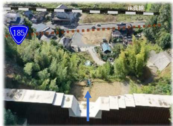
土砂災害対策（大井東下谷川・竹原市）
