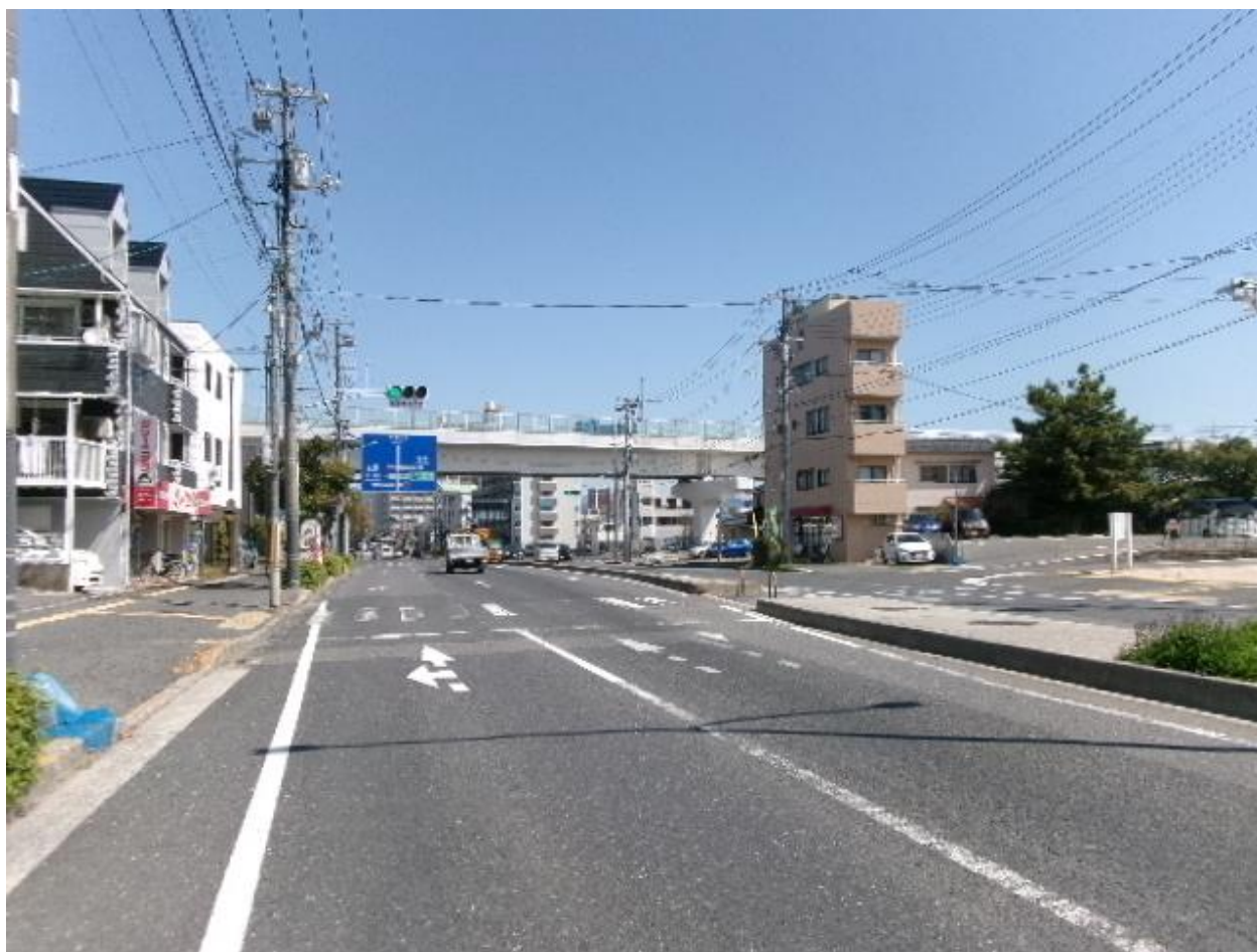
① 移設元：江波南 1 丁目の信号機（北行きの状況・信号機と横断歩道は廃止）
