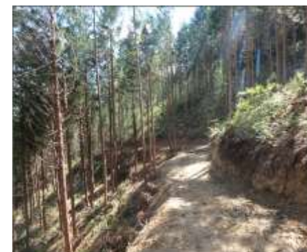
作業道の状況
