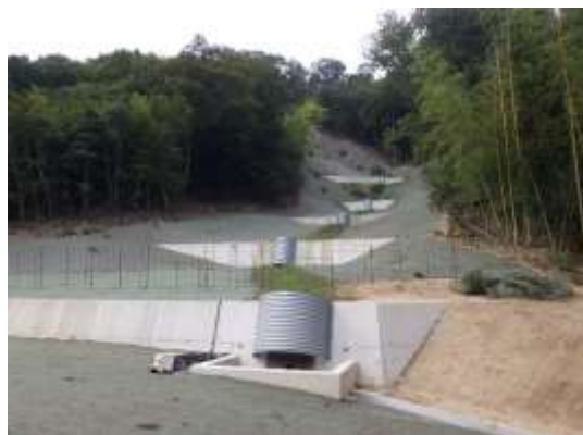
山腹工(土留工)
