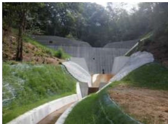
溪間工(谷止工)
