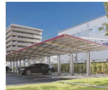
外構・カーポート
