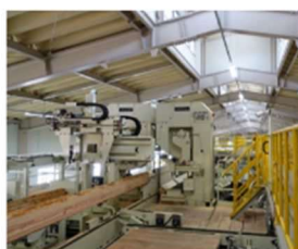
内装材用製材工場
