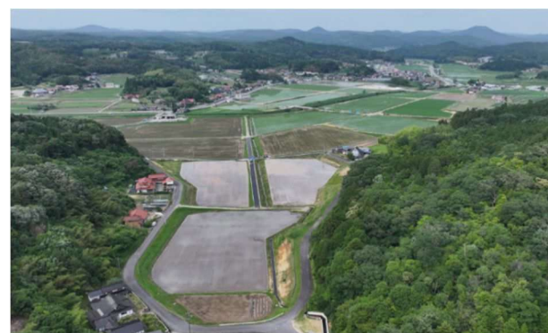
西大田地区 賀茂東工区(世羅町)
