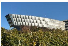
安田女子大学2号館 （石本建築事務所 | 2026）
