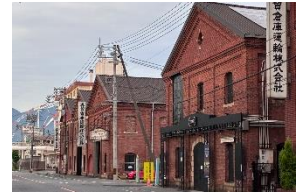
旧呉海軍工廠の煉瓦倉庫群
