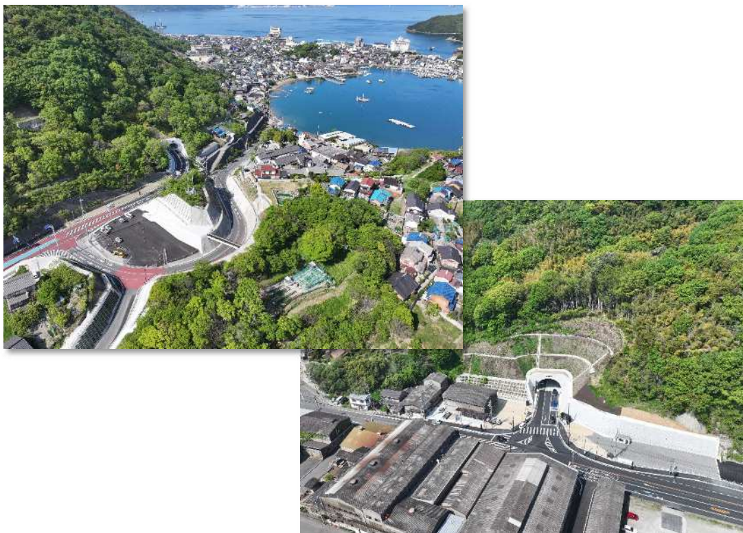
韮松永線バイパス（福山市韮町）
