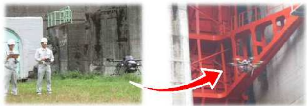
ドローンを活用した施設点検
