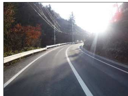
終点側（トンネル東側）
