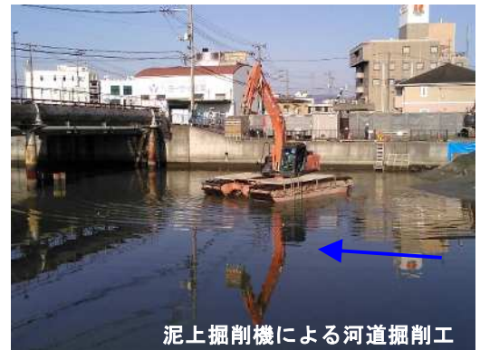
施工状況（河道掘削）
