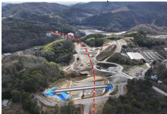
施工状況（瀬戸町周辺）
