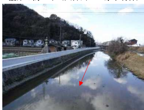
護岸の嵩上げ（天井川：三原市明神）
