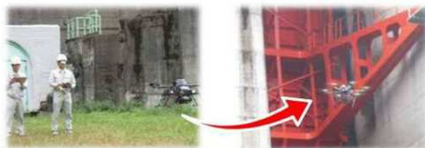
【ドローンを活用した施設点検】
