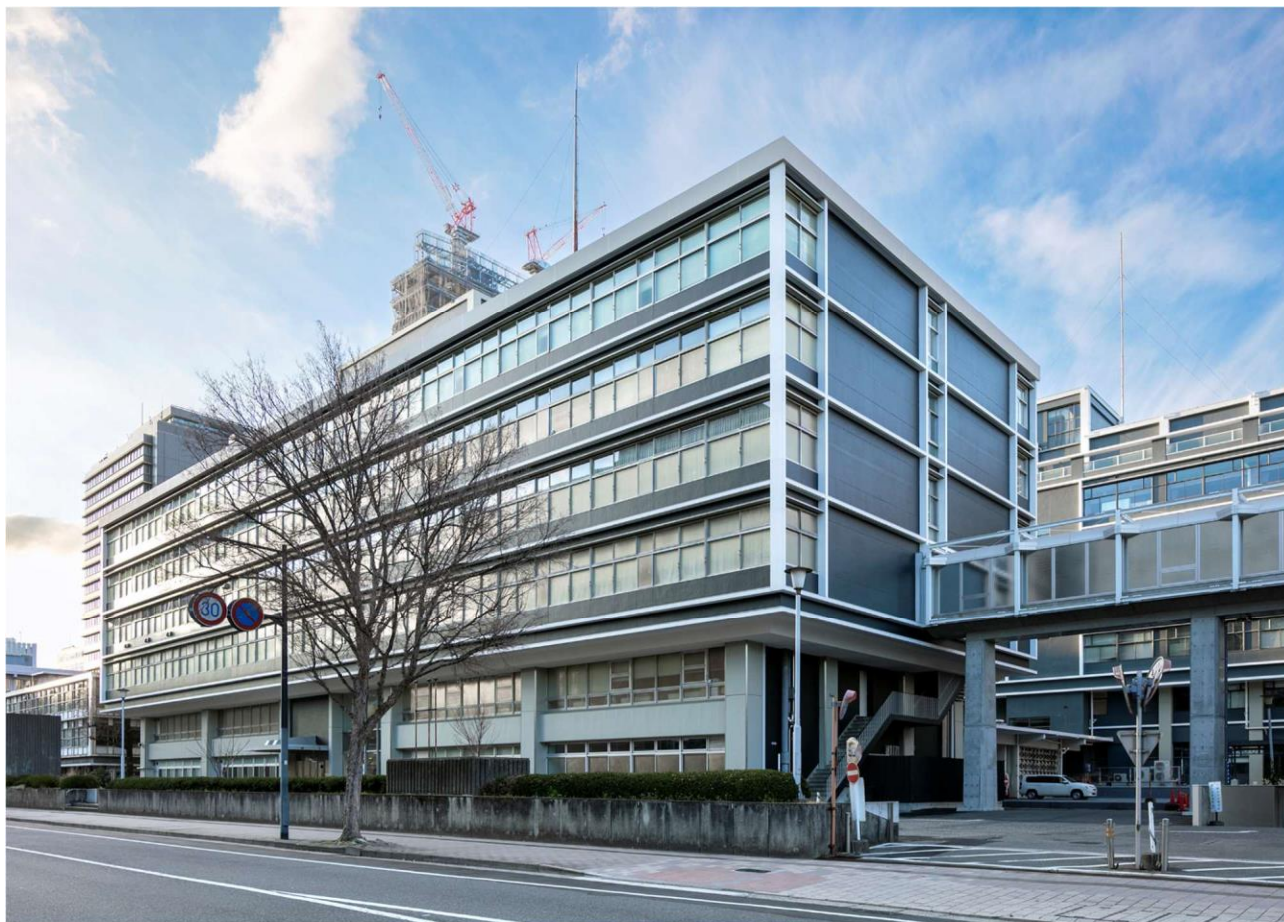
広島県庁北館内外部改修その他工事 完成後全景
