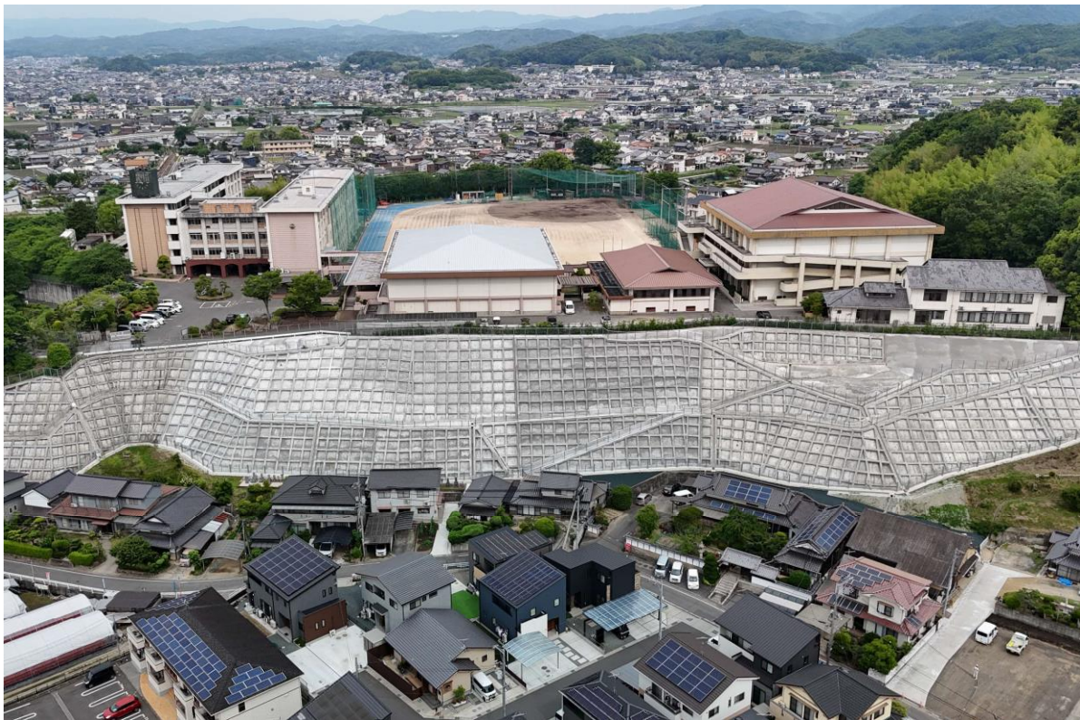
急傾斜地崩壊対策工事 ( 福山市 神辺町 秋丸地区 )
