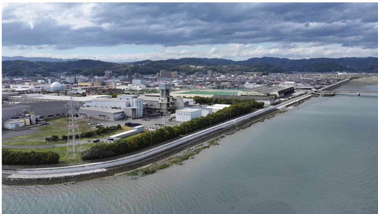
港湾海岸保全施設整備事業 尾道糸崎港海岸高西地区（福山市高西町）
