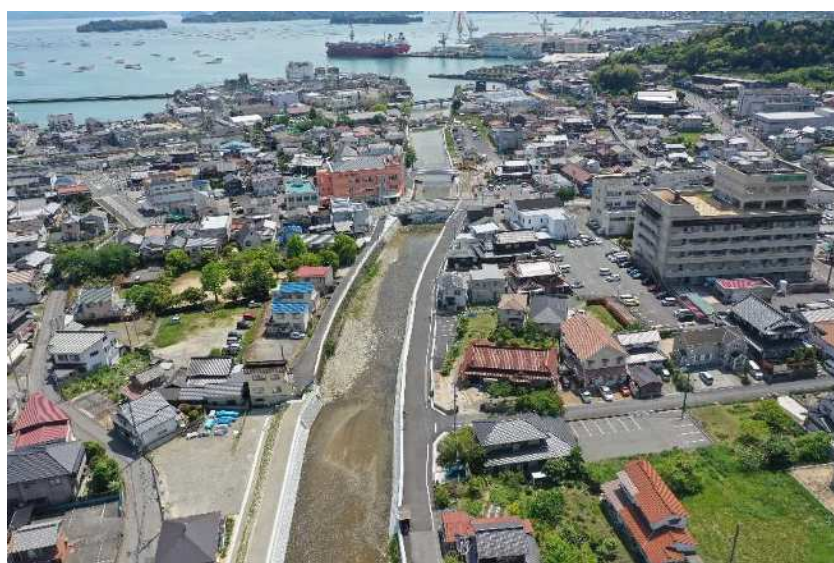
三津大川 災害復旧助成事業完了
