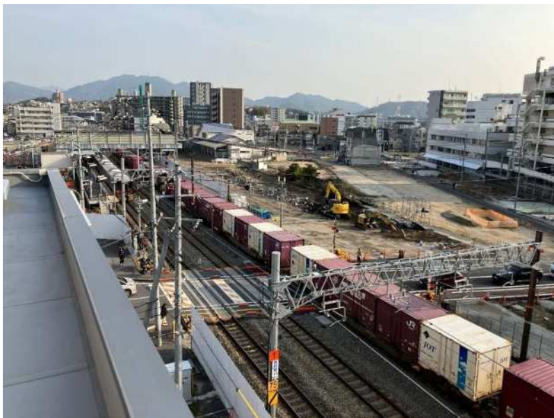
広島市東部地区連続立体交差事業 仮線路完成
