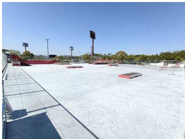
びんご運動公園 アーバンスポーツ施設
