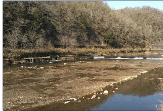
堆積土除去後
