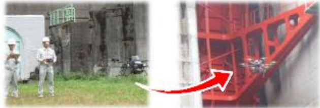
ドローンを活用した施設点検
