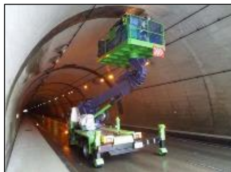
トンネル点検
