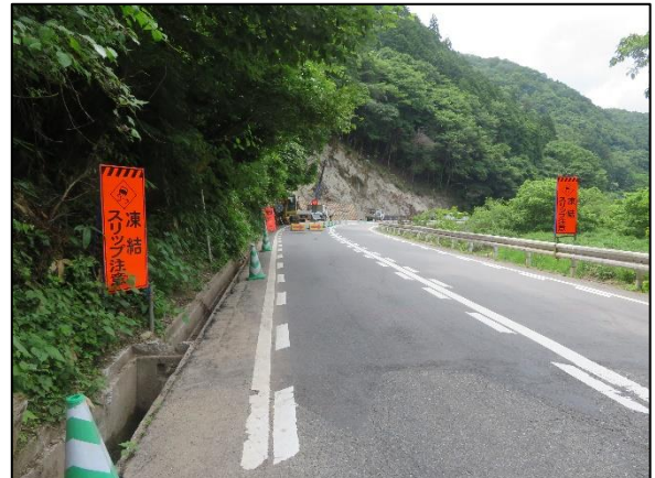
施工状況（応急本工事完了）
