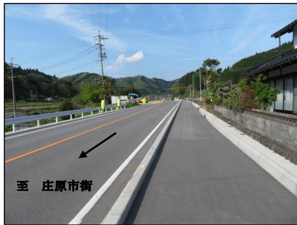
歩道整備状況
