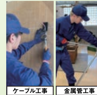
ケーブル工事
