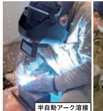
半自動アーク溶接
