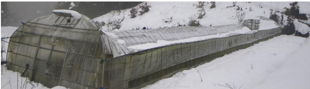
令和4年12月の大雪で全壊したハウス(広島県)
