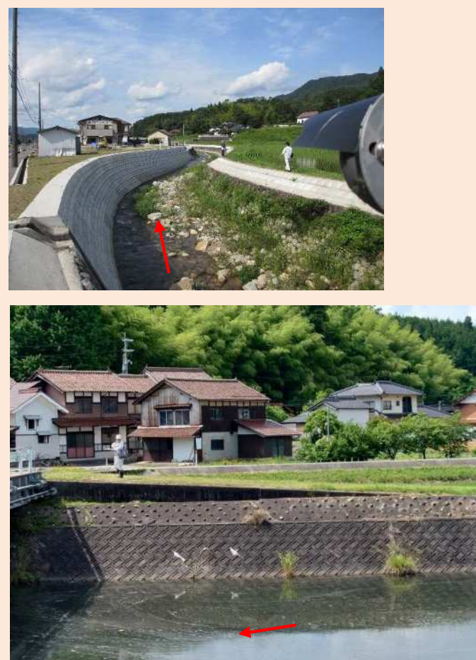
安芸太田支所管内点検状況
