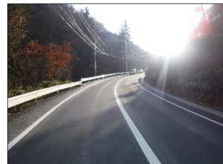
終点側（トンネル東側）
