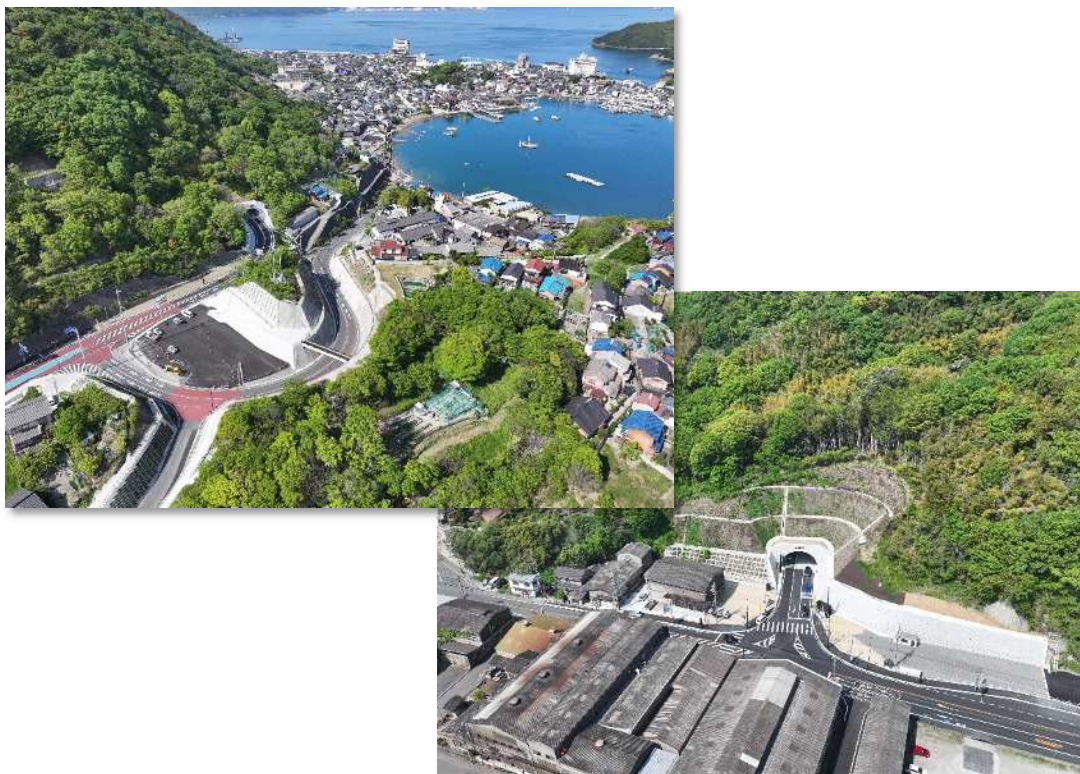
鞆松永線バイパス（福山市鞆町）
