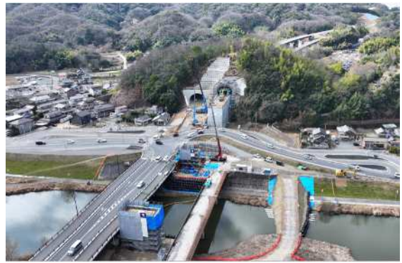
施工状況（草戸町周辺）
