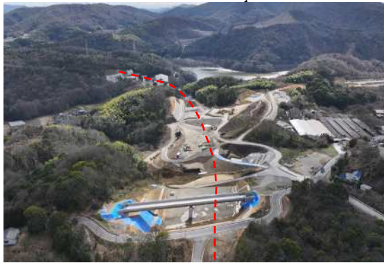
施工状況（瀬戸町周辺）
