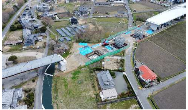
施工状況（福山市駅家町）
