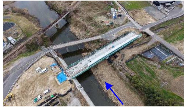
(新) 僧殿橋橋梁上部工事
