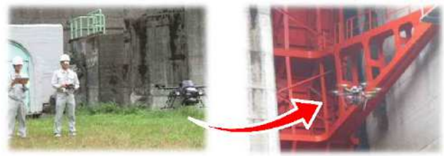
ドローンを活用した施設点検
