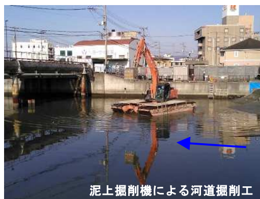
施工状況 (河道掘削)
