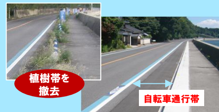
道路空間の再配分による自転車通行帯整備
