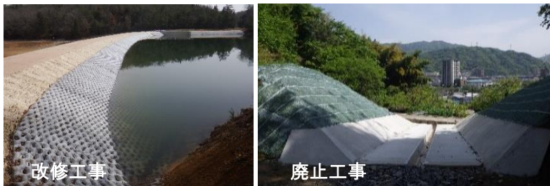
農業用ため池の防災工事
