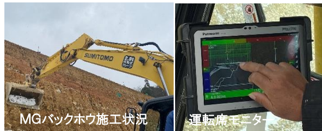
ICT建機による施工状況
