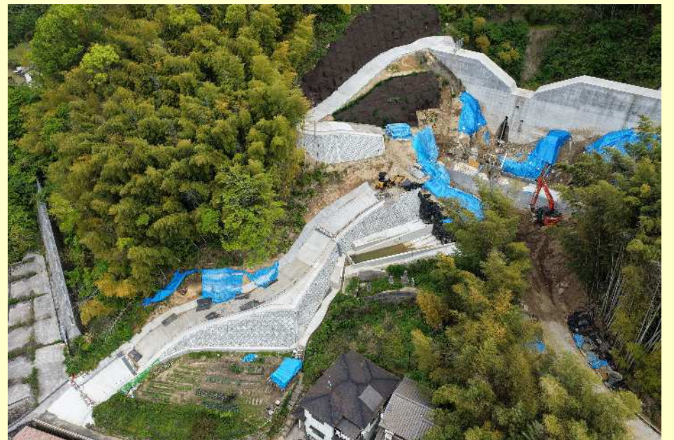
【掘削工(副堰堤部)】
