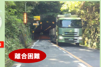
国道487号（江田島市）
