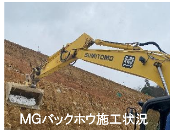
ICT建機による施工状況
