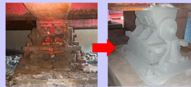
国道191号 加計大橋
