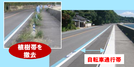
道路空間の再配分による自転車通行帯整備
