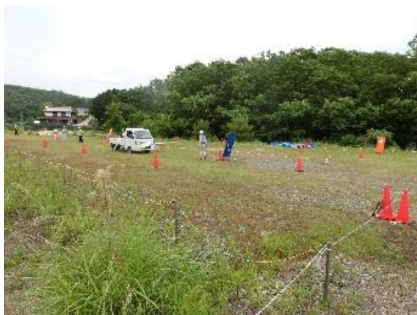
仮置場の設置
