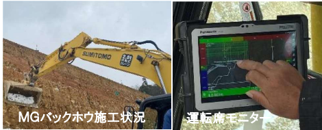
ICT建機による施工状況
