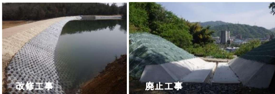
農業用ため池の防災工事
