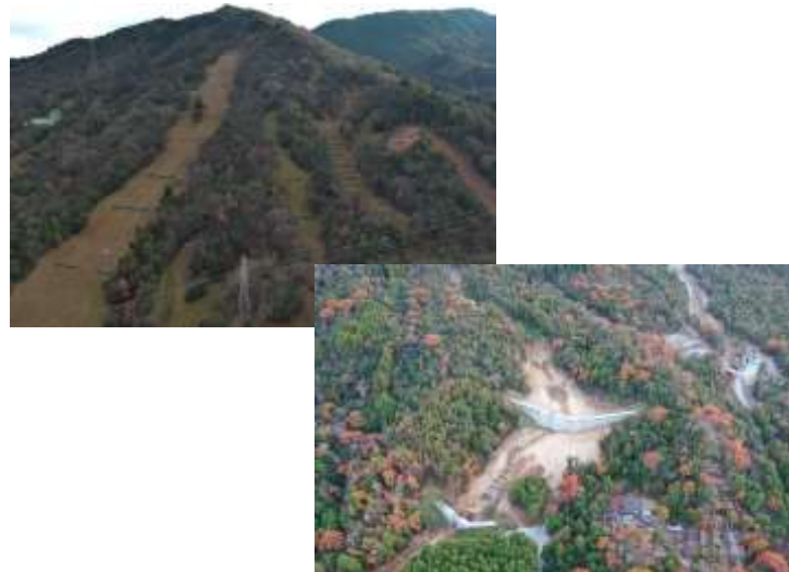
民有林直轄治山事業(東広島市)
