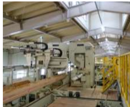
内装材用製材工場
