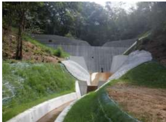
溪間工(谷止工)
