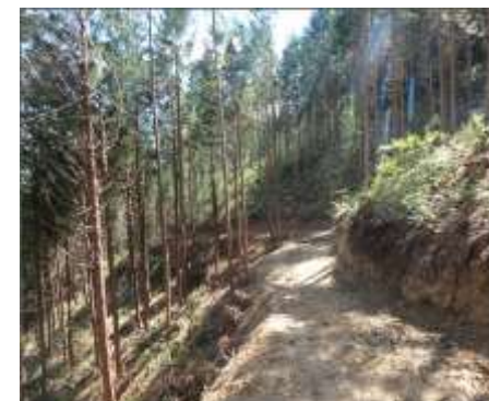
作業道の状況
