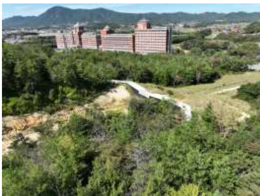
災害関連緊急治山事業等(東広島市)
