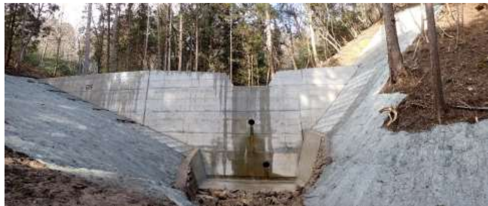
老朽化した 治山ダムの 機能強化 (増厚)
