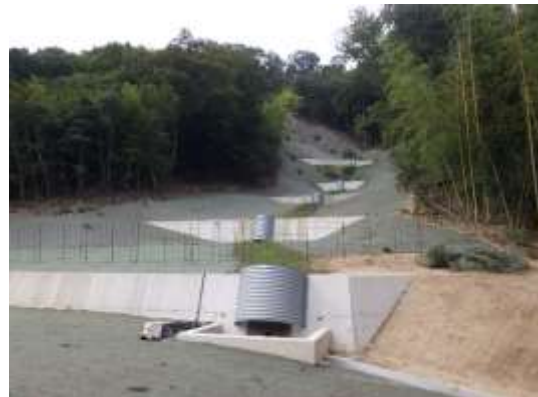
山腹工(土留工)
