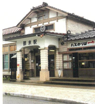
北陸鉄道石川線鶴来駅舎
