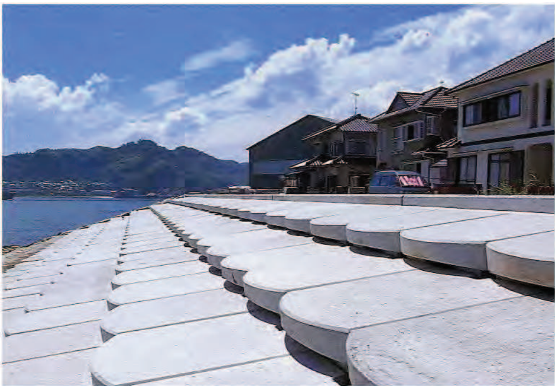
■ 緩傾斜護岸による防護 / 呉市警固屋 呉海岸（警固屋地区） / 高潮対策事業
