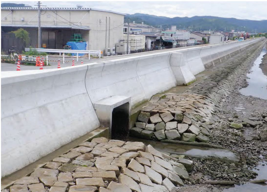
■ 耐震堤防による防護 / 福山市高西町南 尾道糸崎港海岸（高西地区） / 高潮・津波危機管理対策緊急事業
