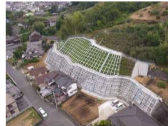
急傾斜地崩壊防止施設の整備
