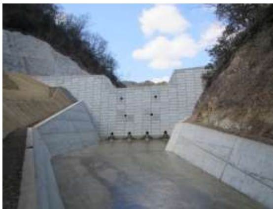
砂防堰堤の整備
