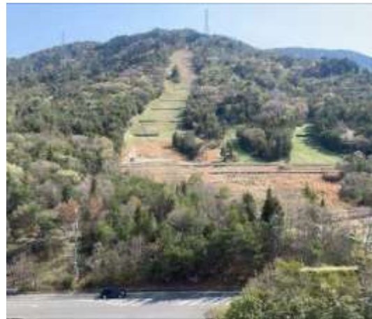
山腹工 施工状況(令和7年4月撮影)
