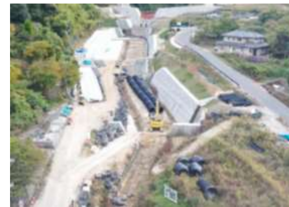
総頭川遊砂地 (安芸郡坂町坂地区)
