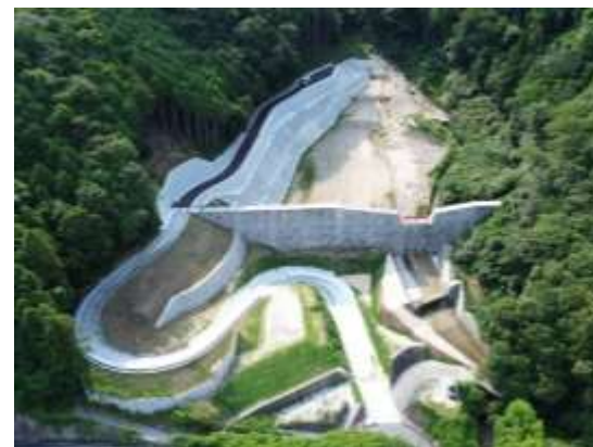
山王川砂防堰堤 (広島市安芸区中野東地区)
