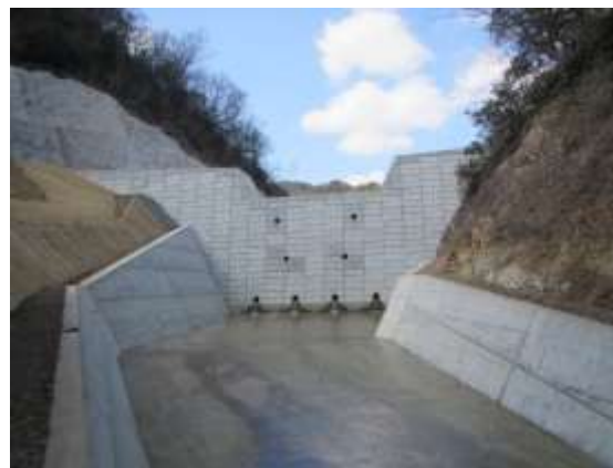
砂防堰堤の整備
