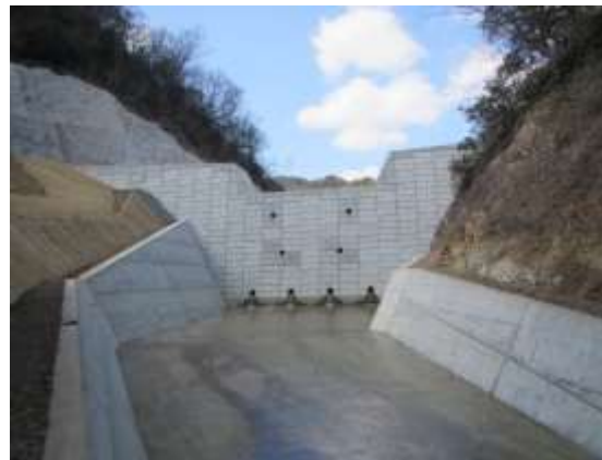
砂防堰堤の整備
