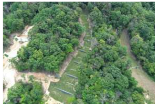
山腹工 施工後の状況(令和6年10月撮影)
