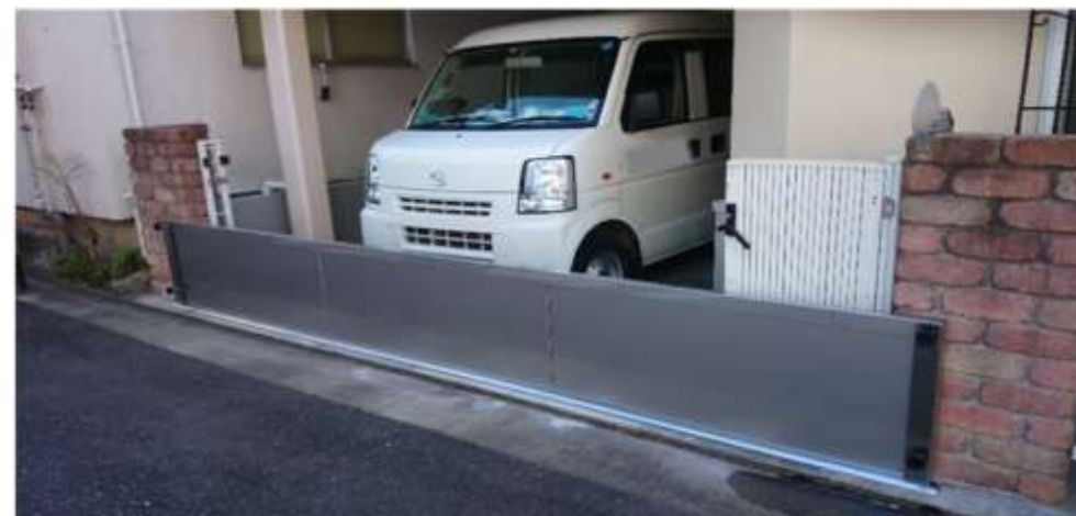
【止水板の設置例】
