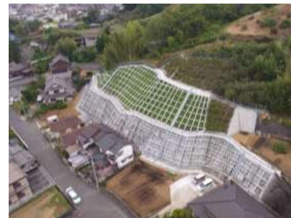
急傾斜地崩壊防止施設の整備
