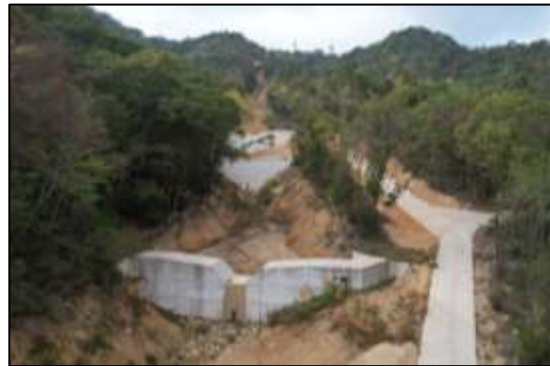
溪間工 施工後の状況(令和6年11月撮影)
