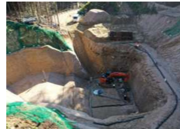
倉重2号砂防堰堤(広島市佐伯区)
