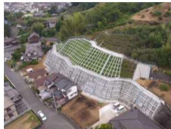
急傾斜地崩壊防止施設の整備
