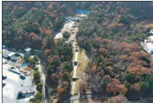
全景 施工後の状況(令和6年4月撮影)
