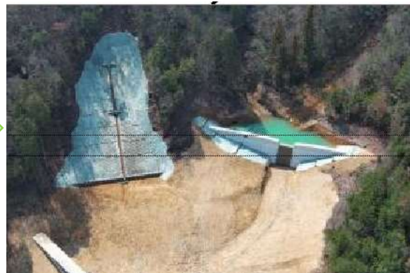
上流部(溪間工、山腹工) 施工後の状況(令和7年3月撮影)
