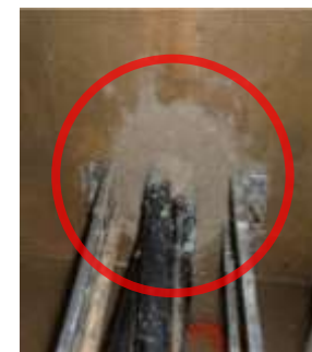
ケーブル貫通部の閉塞
