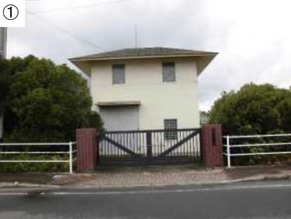
①施設外観 ②縦軸軸流ポンプ φ700mm
