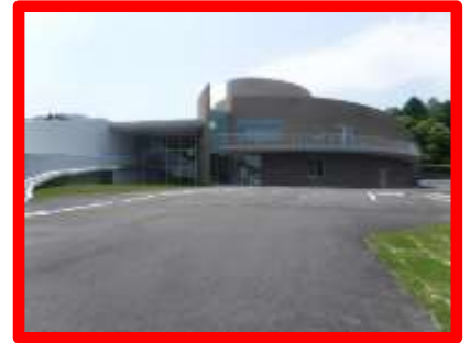
熊野東防災交流センター
