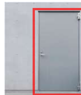
防水扉の設置
