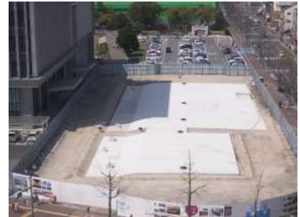
施設全景(工事中)
