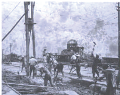
相生橋の復旧工事(昭和21[1946]年) (撮影：岸本吉太氏、所蔵：岸本坦氏)
