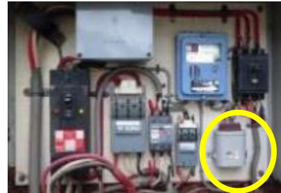
低圧分電盤内の低圧コンデンサー
