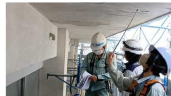
外壁改修工事での調査の様子
