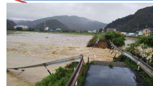
天井川における破堤(三原市)
