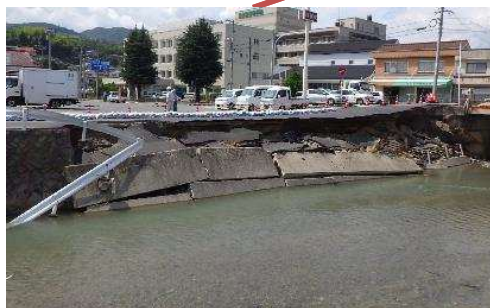
三津大川の護岸崩壊(東広島市)
