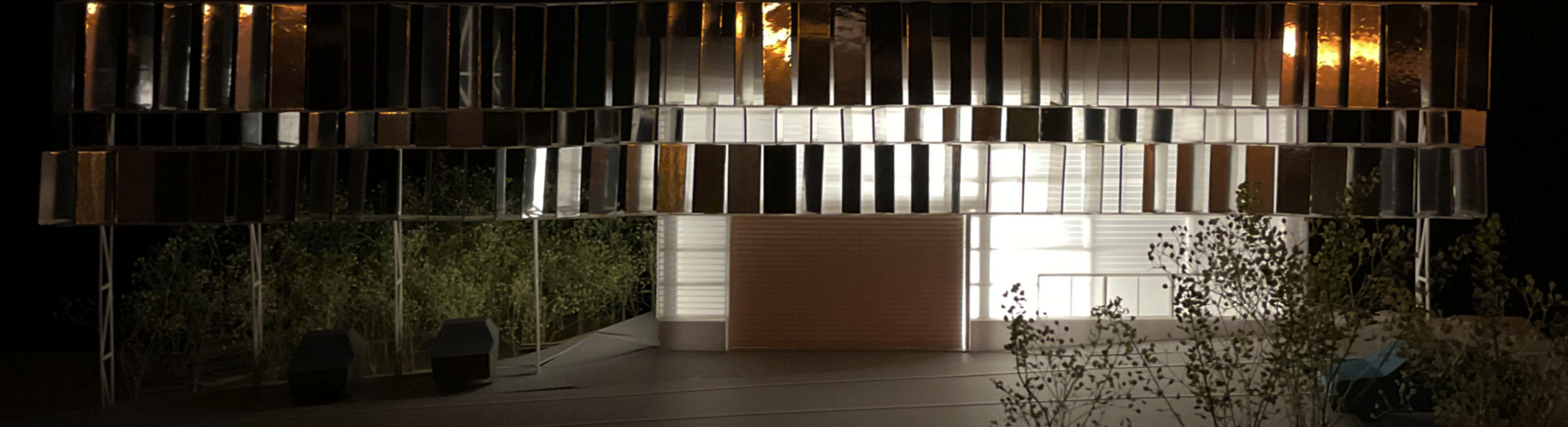
夜の道しるべ：日中に太陽光発電された電気を蓄電し、屋内のLED照明が外壁を覆う納入波板ガラスを通して道を照らす。常夜灯のような『道しるべ』になる。
