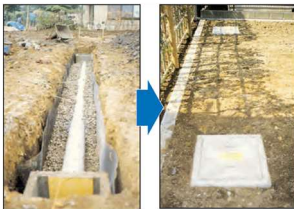
浸透トレンチ
