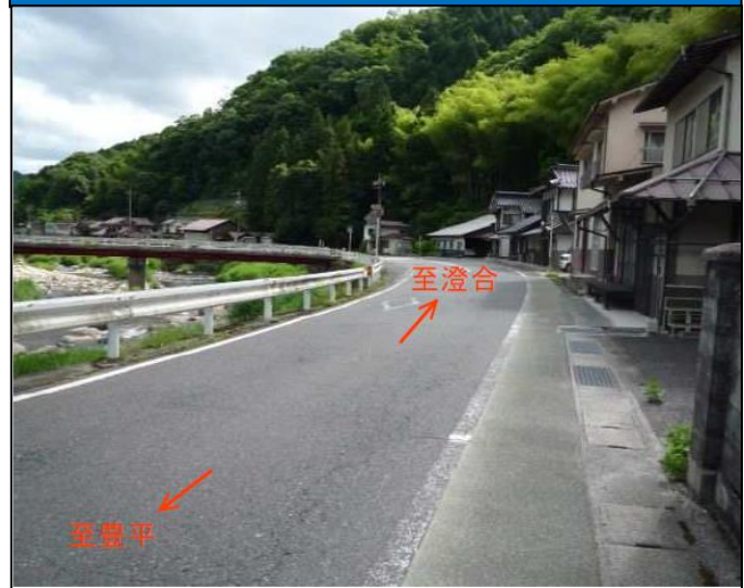
【施工前の状況】
