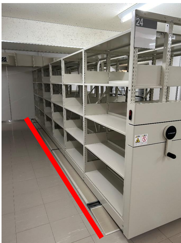
A2-2 期レール・床張り始点（A2-1 期との接続部分）
