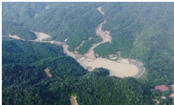
写真 2009年（平成21年）7月21日山口県防府市豪雨災害で被災した玉泉ため池 複数の土石流がため池に流入したが、決壊することなく、土石流を停止させ、下流への被害を防いでいた。（2009年7月22日海堀撮影）
