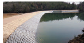
整備後のため池(大池:三次市)
