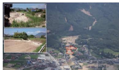
平成30年7月豪雨でのため池被災(東広島市)
