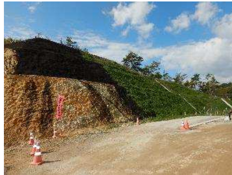
ノンラスグリーン工法施工状況
