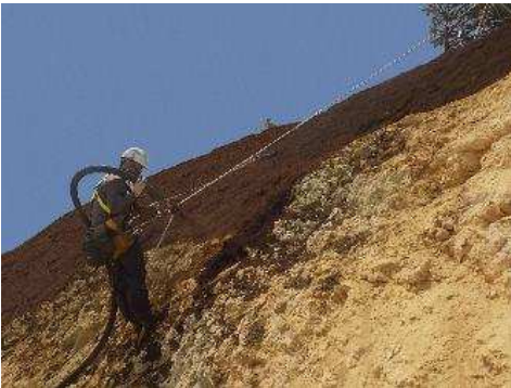
ノンラスグリーン工法施工状況
