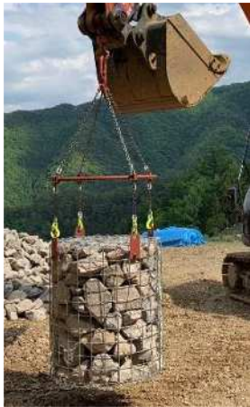
かご丸くん吊り施工の様子
