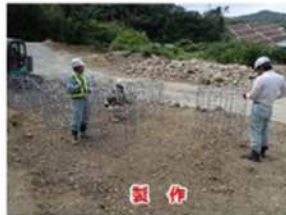
バックホウによる填石の中詰め
