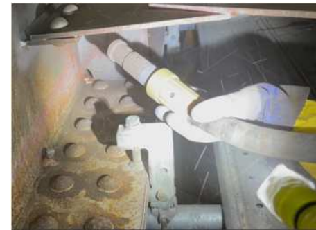
狭隘部への施工状況
