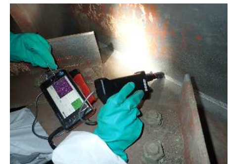
狭隘部への施工状況
