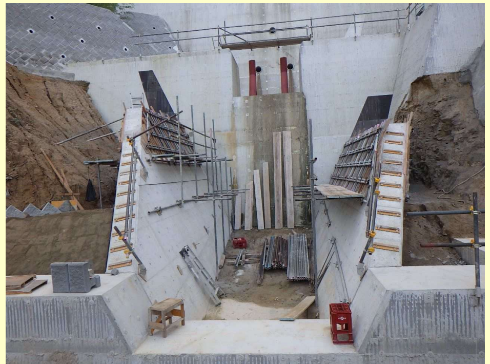
【側壁工(副堤～第一垂直壁)】
