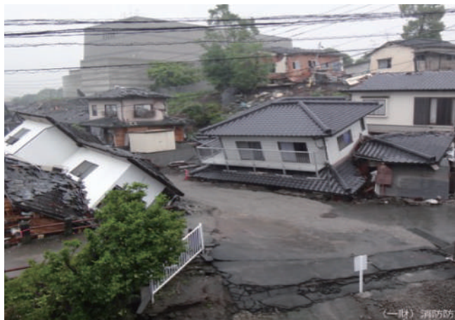
地震による建物の倒壊
