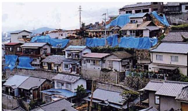
おお じゅうたく ひが 多くの住宅に被害が生じた様子(呉市西三津田町) しゅつてん げい よ じ しん かか みんかんたくち ようへきふつきゅうじぎょう きろく 出典:芸予地震に係る民間宅地擁壁復旧事業の記録
