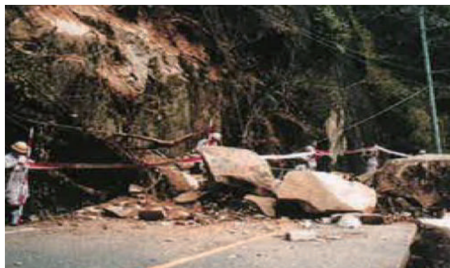
どうろ らくせき 道路への落石(現在の東広島市河内町) しゅつてん げい よ じ しん かか みんかんたくち ようへきふつきゅうじぎょう きろく 出典:芸予地震に係る民間宅地擁壁復旧事業の記録
