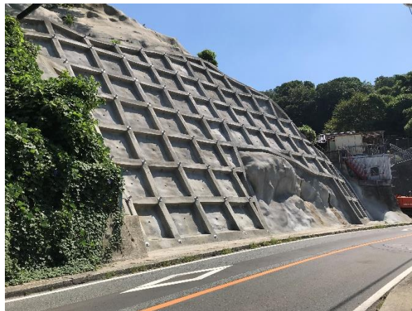
主要地方道音戸倉橋線 呉市音戸町
