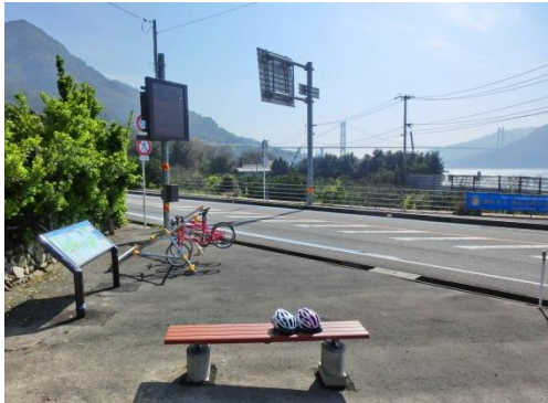
道路余裕地を活用した休憩施設
