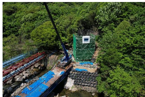
上二河地区の工事状況
