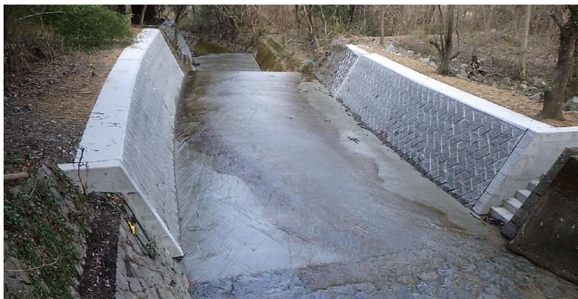
(砂) 荒采川 砂防災害復旧工事
