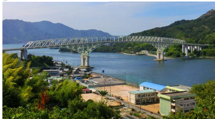
一般国道487号 早瀬大橋
