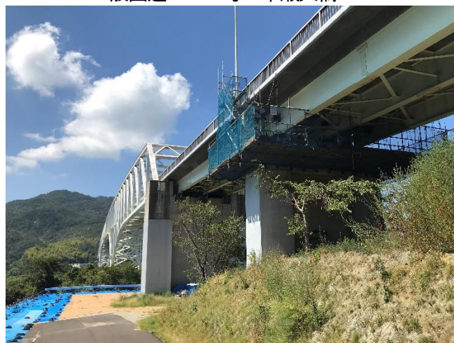
耐震補強施工状況（P1橋脚）
