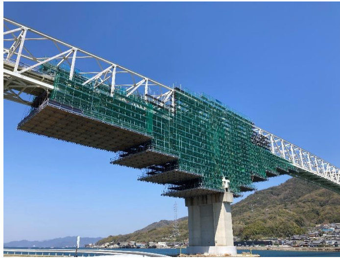
上部工補修・耐震補強施工状況
