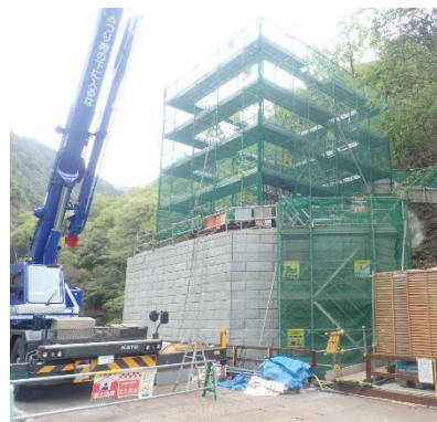
上二河工区の工事状況
