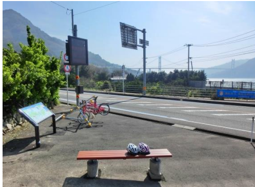
道路余裕地を活用した休憩施設
