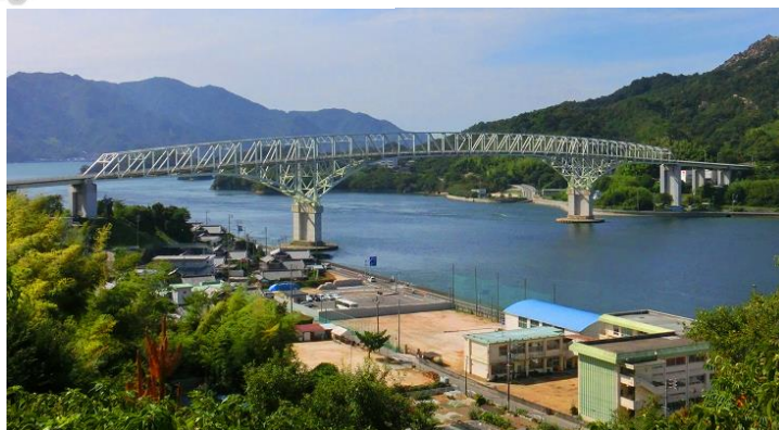
一般国道 487 号 早瀬大橋
