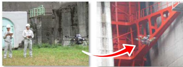
【ドローンを活用した施設点検】
