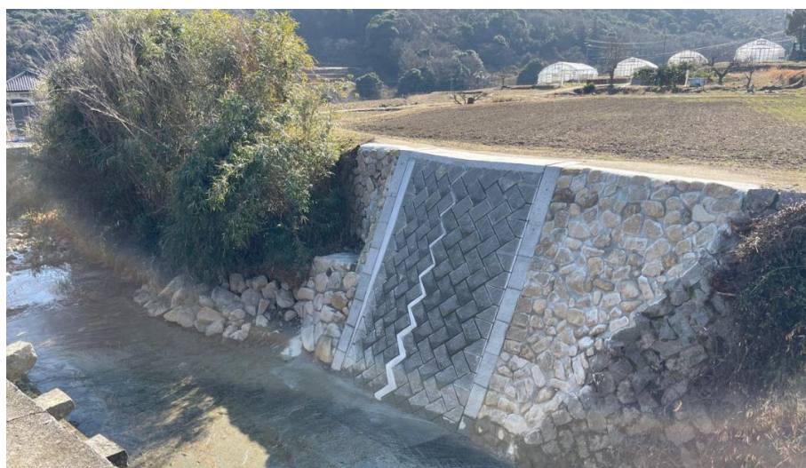
令和 6 年（砂）中切川 砂防設備災害復旧工事
