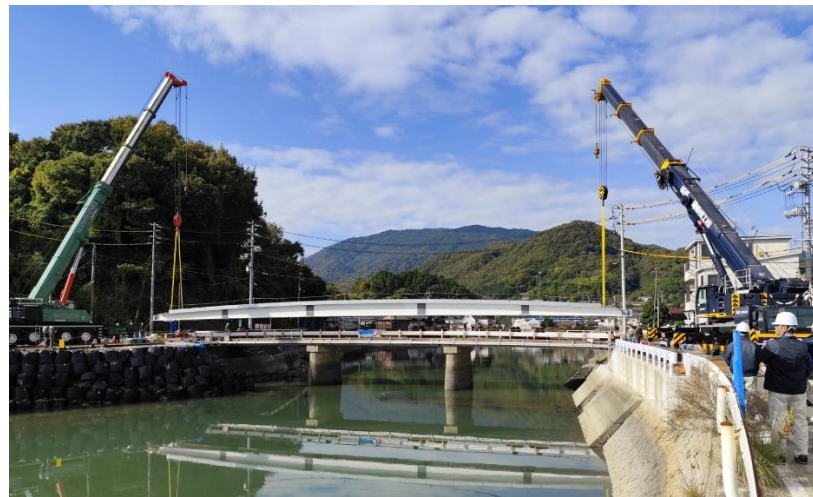
一般県道川尻安浦線 呉市安浦中央 歩道橋施工状況
