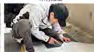
内装実習(床タイル貼り)
