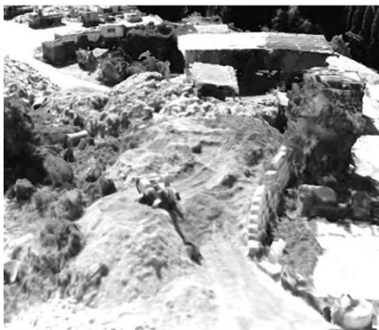
図1 保管場所Aの3Dモデル (空撮画像を3D化处理)
