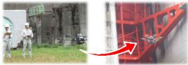
ドローンを活用した施設点検
