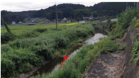
堆積土除去前
