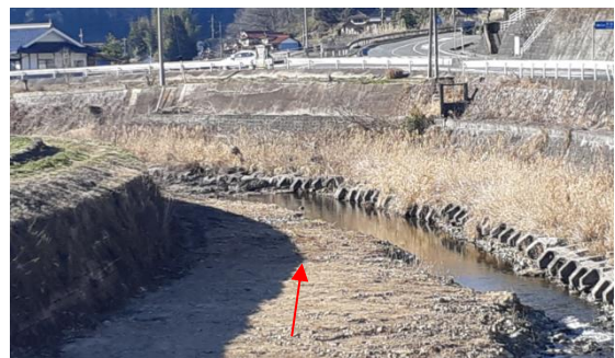
堆積土除去後
