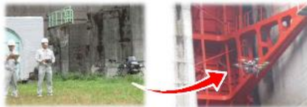
ドローンを活用した施設点検
