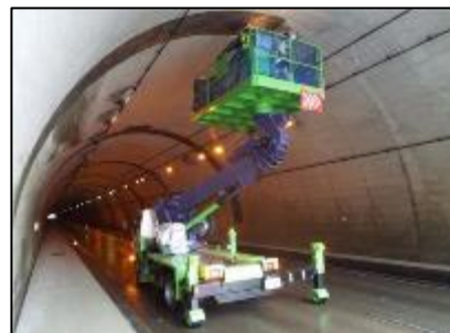
トンネル点検
