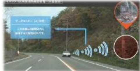
道路法面の崩落予測技術
