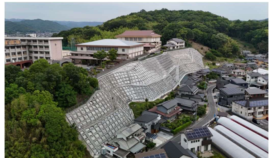
整備後(令和7年6月)
