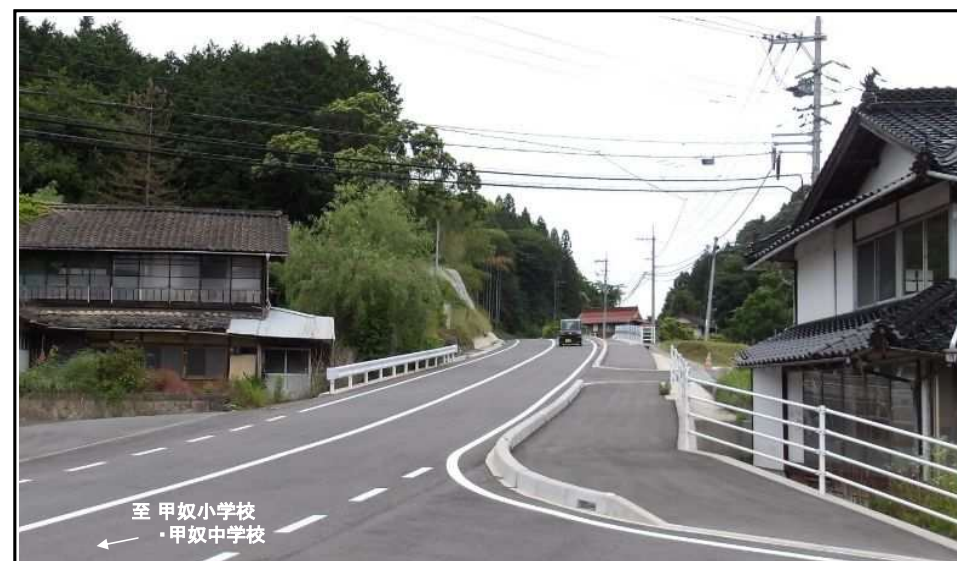
整備後(令和7年6月)
