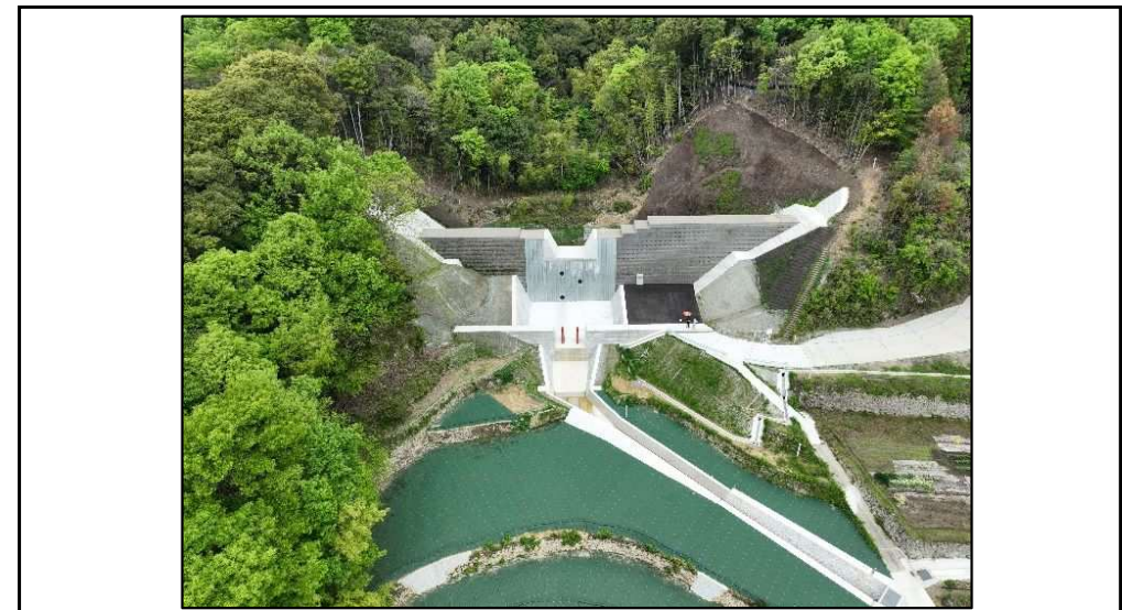
整備後(令和6年4月)
