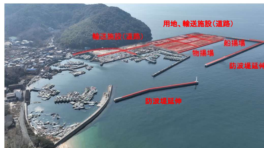
整備後(令和7年2月)
