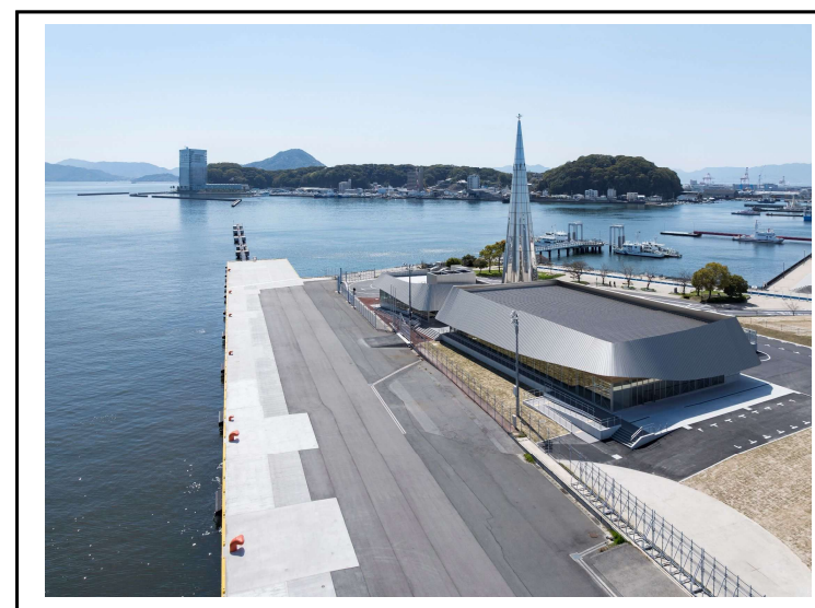
整備後(令和6年4月)
