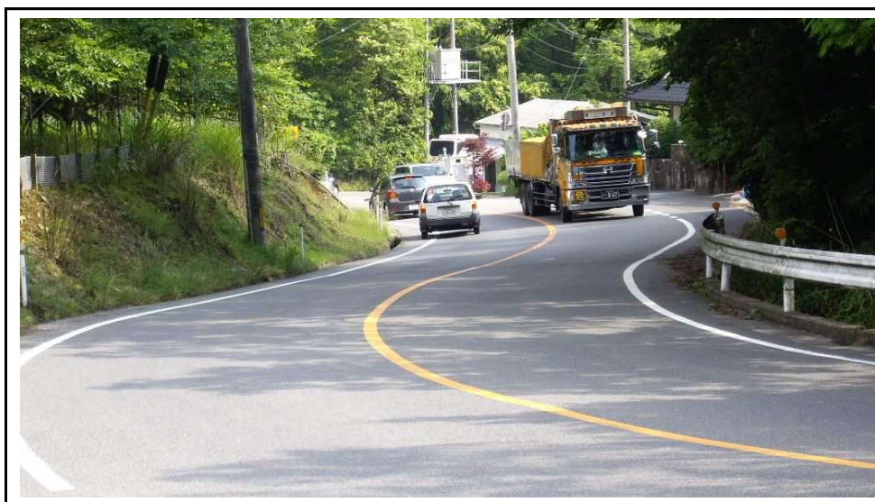
整備前(勾配が急で線形の悪い現道)
