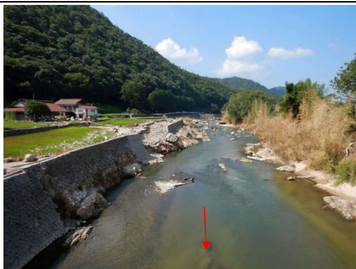
整備前(平成30年7月)
