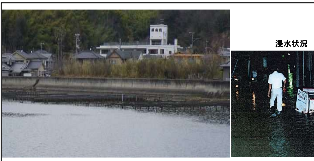
整備前(平成21年2月)
