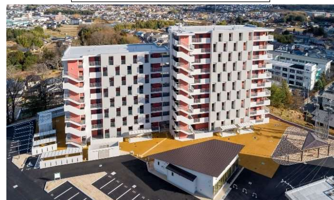
整備後(令和7年1月)
