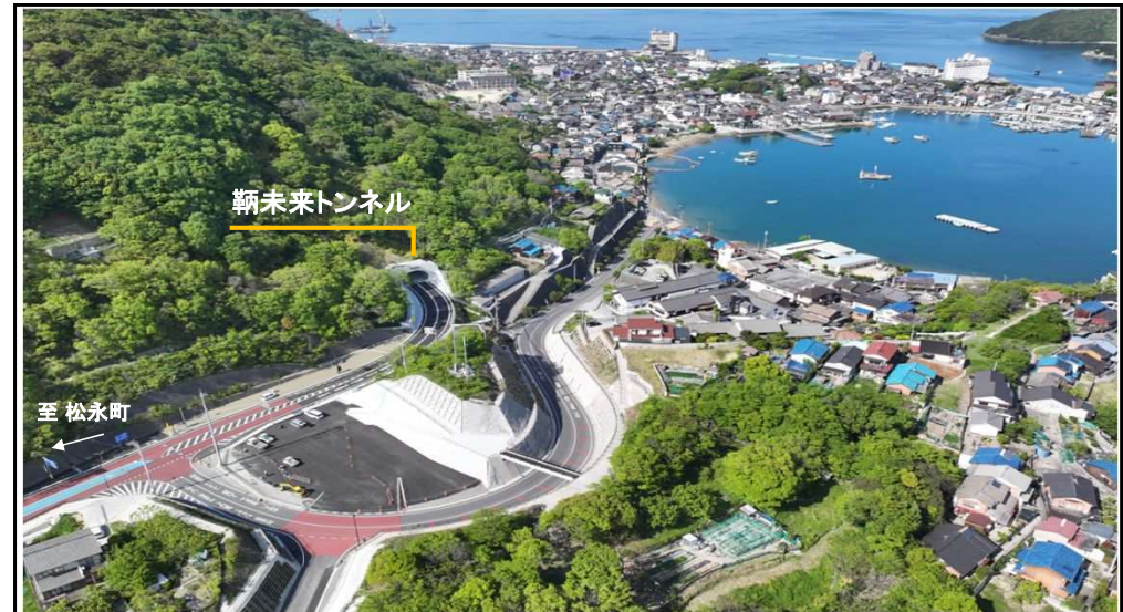
整備後(令和7年4月)
