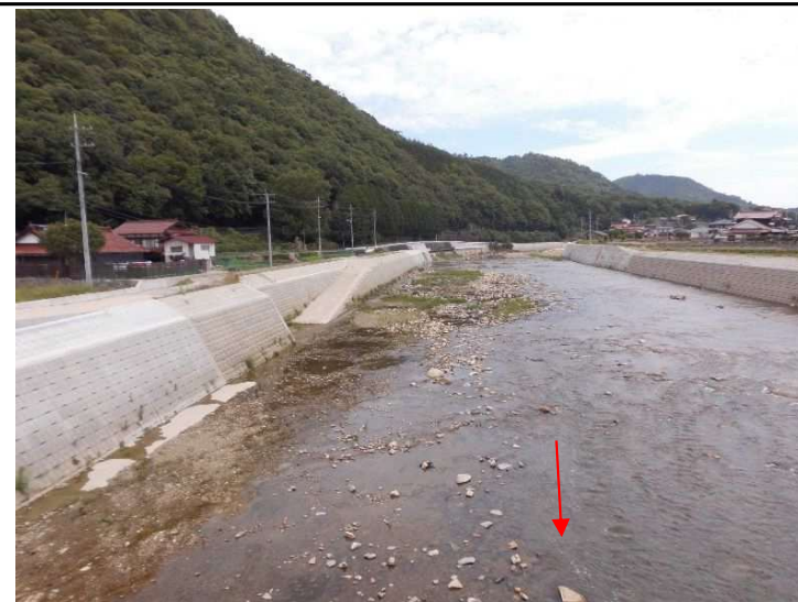
整備後(令和7年6月)
