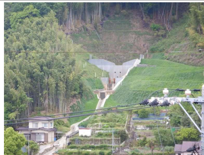
整備後(令和5年3月)
