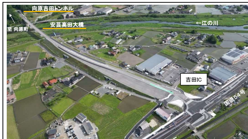
整備後(令和7年5月)
